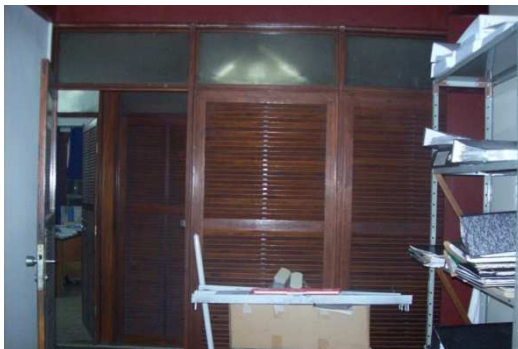
Esquadrias das salas/escritórios em madeira (Fonte: Arquivo da equipe)
