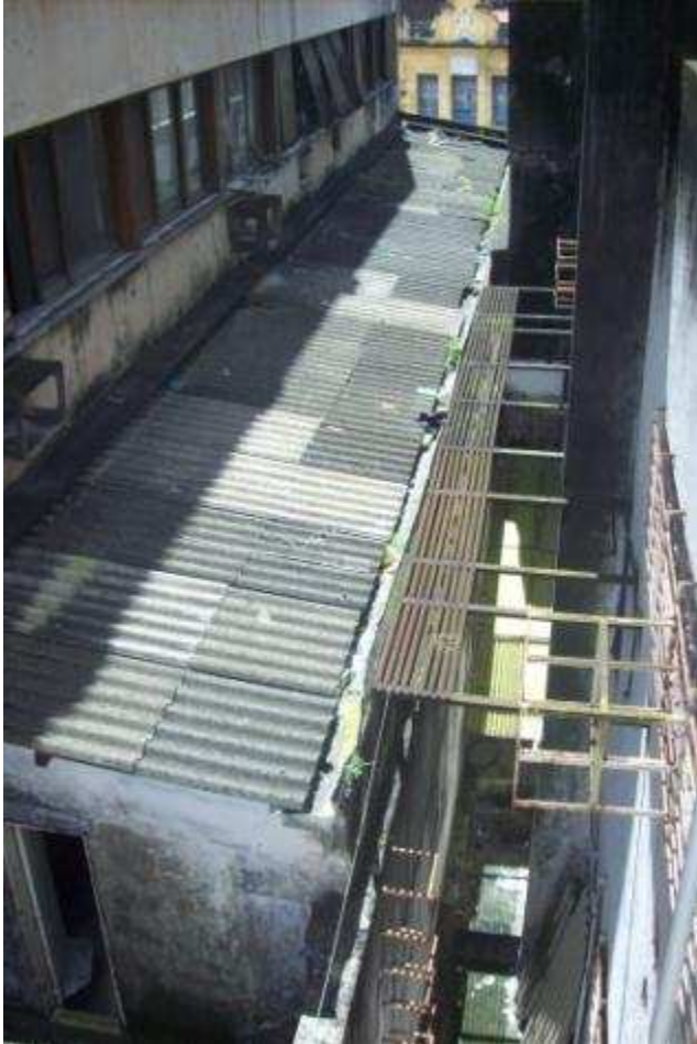
Anexo que abriga parte do Banco Real
