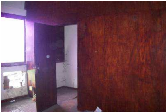
Divisórias internas em madeira
