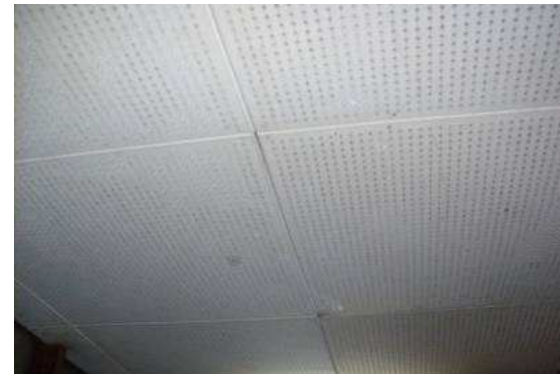
Forro acústico na circulação horizontal (Fonte: Arquivo da equipe)
